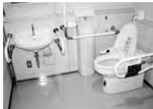
広々とした身障者用トイレ室。車椅子のまま入室できます。
